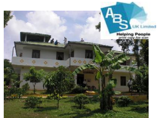
Photovoltaik-Anlage wird installiert
