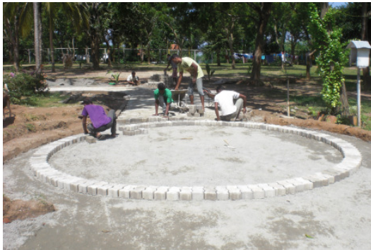
Bau des Eliya Rondells am Hauseingang
