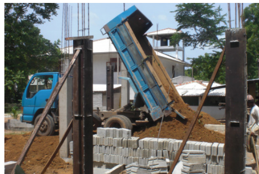
Baustelle Eliya Krankenstation (Hauptgebäude im Hintergrund)
