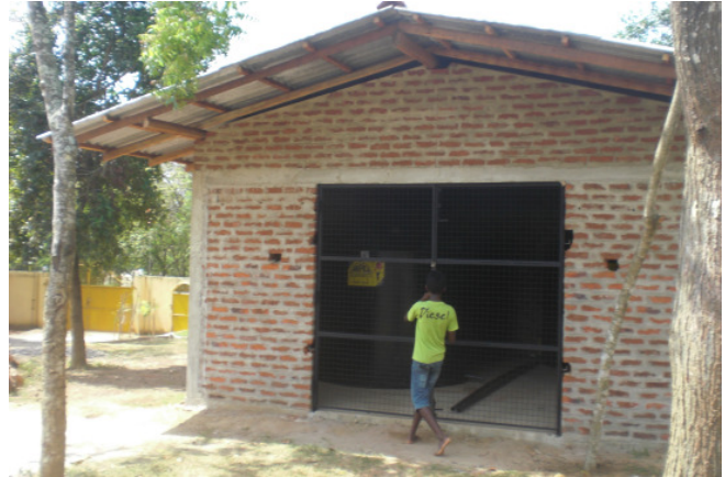
Wasserspeicherhaus ist fast fertig!
